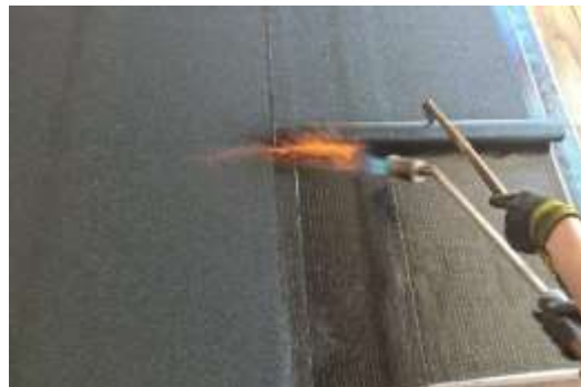
Photo 8 : Soudure en plein de la seconde couche
