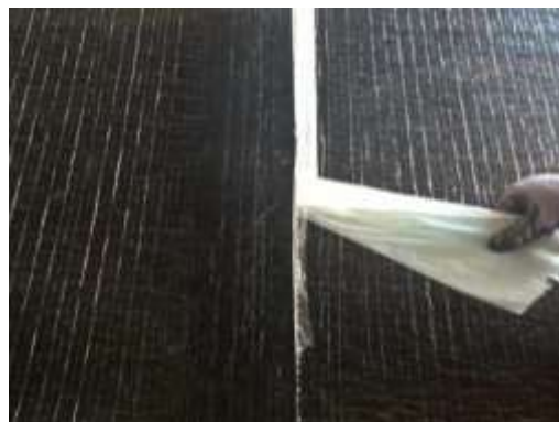
Photo 6 : Retrait du film pelable et marouflage
