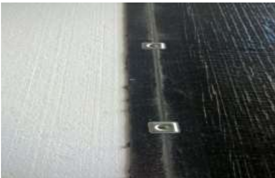
Photo 3 : Mise en place des fixations mécaniques
