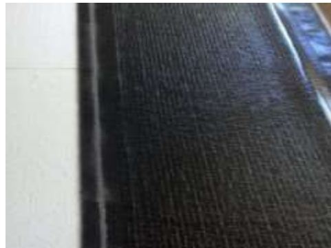
Photo 2 : Retrait du film pelable supérieur
