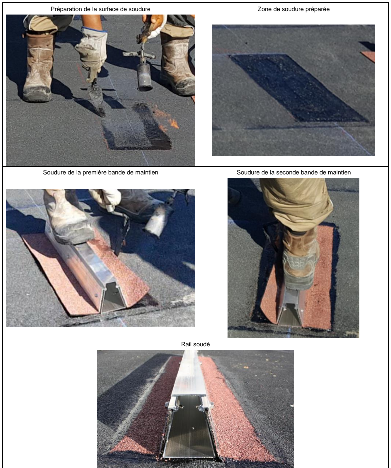
Figure 19 - Soudure d'un rail
